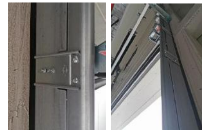
轨道段冷桥设计
